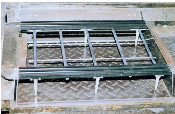
■縦打ち(手掛け横)のセット・打設・脱型・堆積状況
