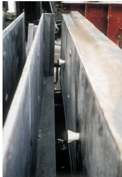
▲床版ブロック L=2m タテ打ちの型枠への取付状況 (NV20×70使用)
